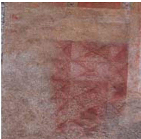
11. Un particolare a restauro ultimato.
